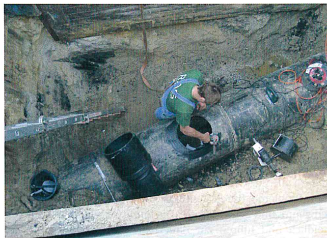
Abb. 3: Die größere Öffnung wird vorbereitet.
