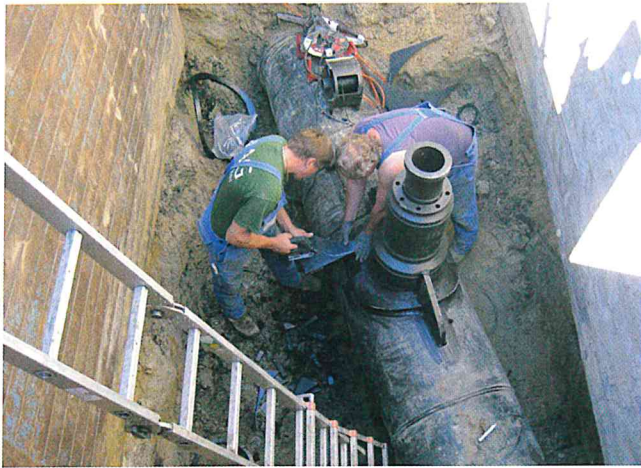
Abb. 4: Einbau des leistungsstärkeren Entlüftungsdoms
