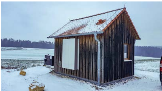
Abb. 1: Außenansicht des Pumpwerks
