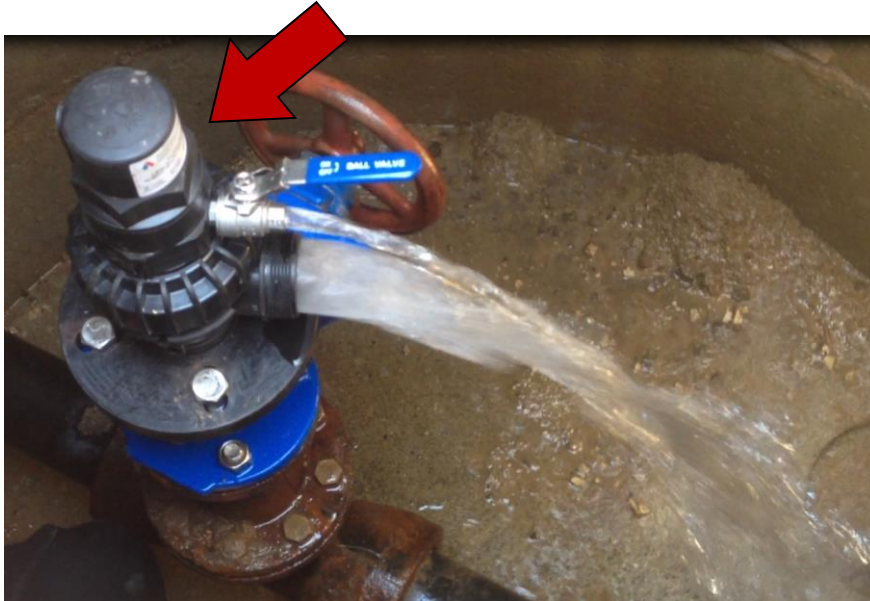
Foto: Austretendes Spülwasser bei geöffnetem Spül-/Entspannungshahn (roter Pfeil)
