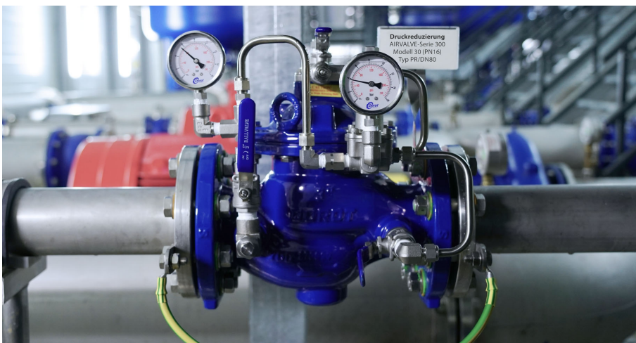
Installation eines AIRVALVE Druckreduzierventils (Serie 300, Modell 30, Typ PR, DN80, PN16) in einem deutschen Wasserwerk
